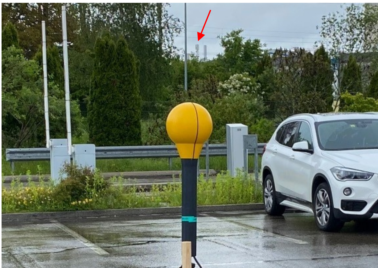
Photo 5: Basisstation (roter Pfeil) und Messantenne
