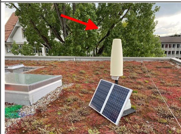
Figura 15: Sito di misurazione #2 Tetto aula
