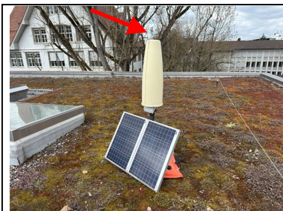
Figura 5: Sito di misurazione #1 tetto aula magna
